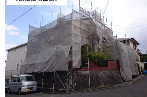
＜仮設足場全景＞
