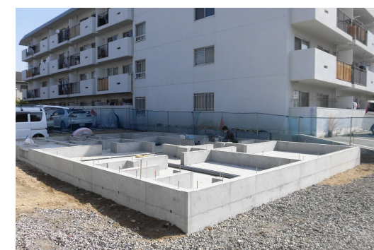
【コンクリート打設後の基礎全景】
