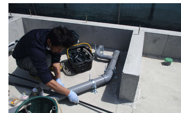
【設備配管の先行工事】
