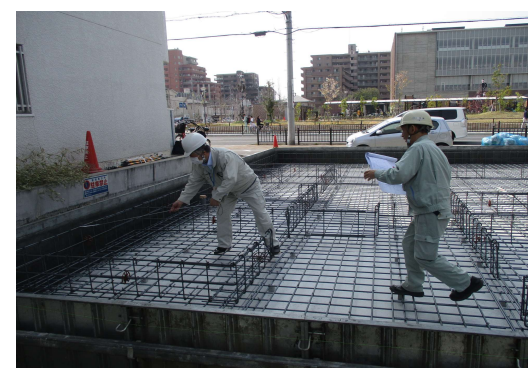
【第三者機関による基礎鉄筋 配筋検査】
