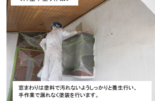
＜外壁下塗り作業＞
