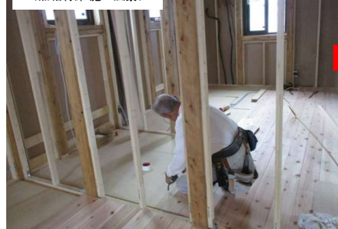
<無垢材床 施工風景>
