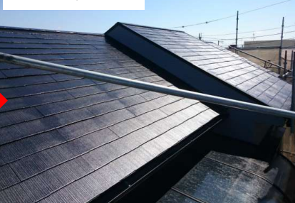
<屋根塗装完了>
